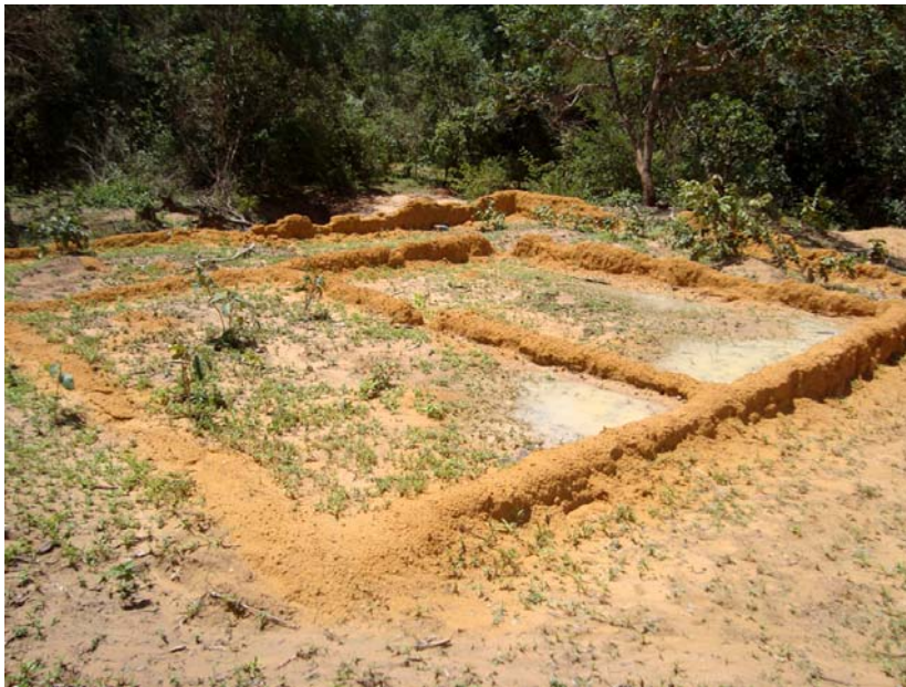
Restos de uma casa de taipa que tende a se tornar mais e mais tênue com os sucessivos invernos.
