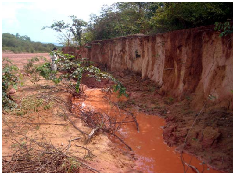
Área erodida ao lado da rodovia.
