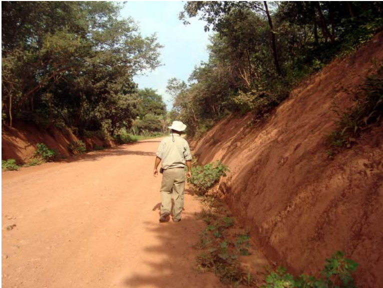
Corte para a abertura da estrada
